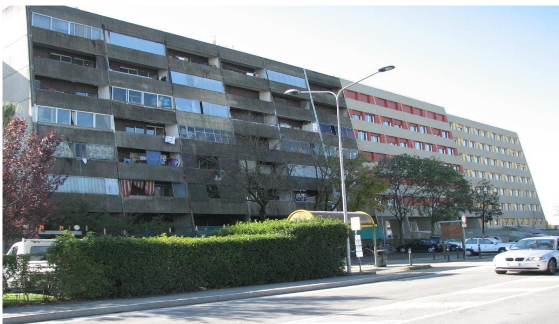
Immagine 1. A sinistra il Blocco 3 prima degli interventi di ristrutturazione, a destra caratterizzati dal rosso e il giallo i Blocchi 1 e 2 già ristrutturati.
